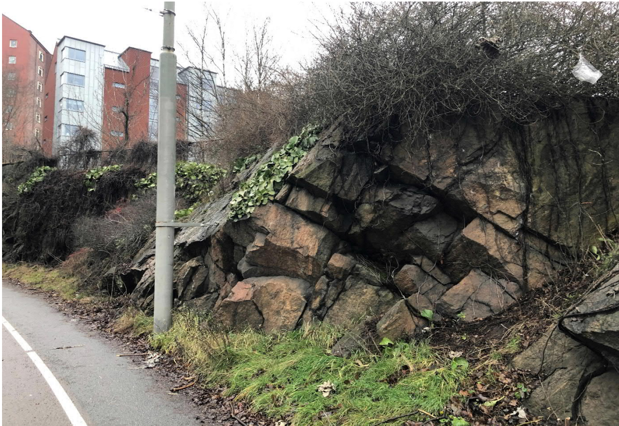
Figur 10 Mindre slänt mot Aschebergsgatan
